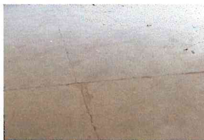
Foto 2: 170 mts cuadrados de ceramico, de tres aulas
