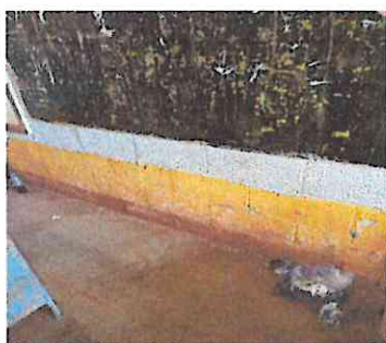
Foto 3: Pintar paredes de las tres aulas, cocina, baños y salon de usos multiples.
