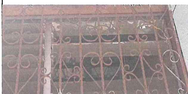
Foto1: Susuticion de 30 metros de ventanas pvc. Una aula y cocina
